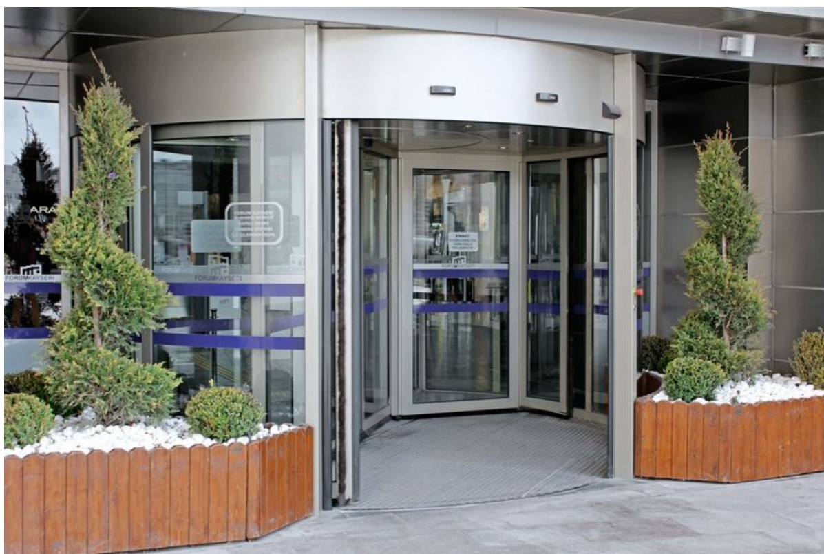
Sistema automatico di porta girevole a due ante con porta scorrevole integrata
